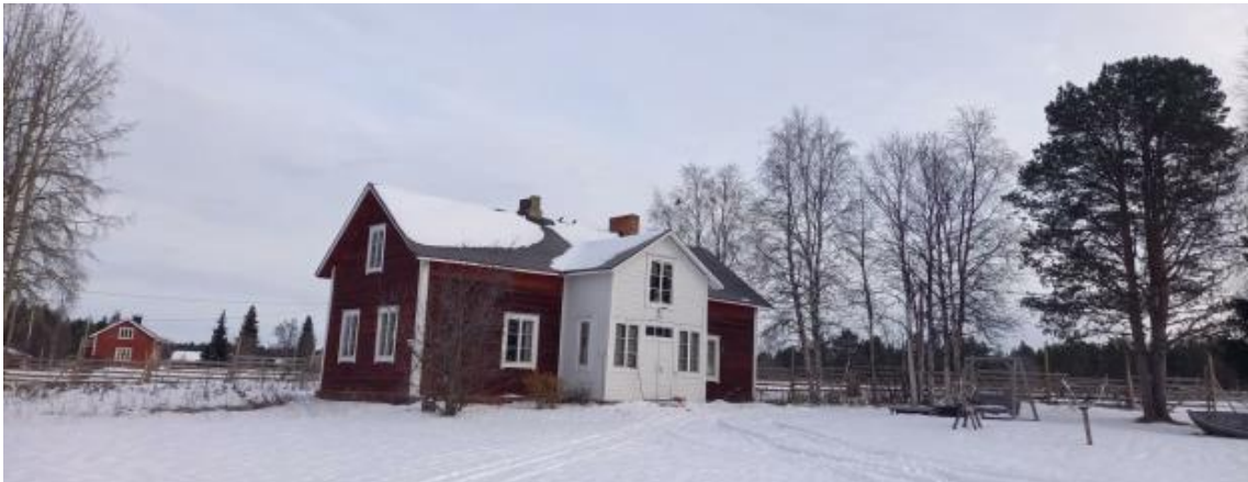
Kuva 8. Lapinkartanon päärakennus on 1930-luvulta. Kuva: J. Lokio 2023.
