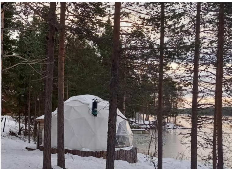
Kuva 12 (vasen). 2010- luvulla rakennetut nk. glamping-majoitteet ovat jo tulleet elinkaarensa päähän. Kuva J.Lokio 2023.
